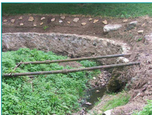
Photographies 6: Consolidation des berges par enrochement (photo de gauche) et par des tôles sur le ru de Bézu (photo de droite)
